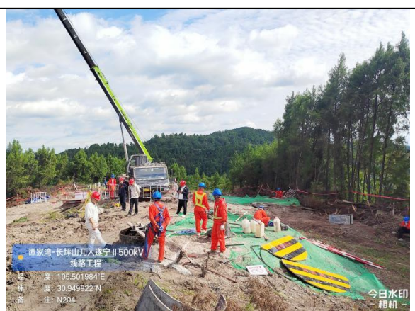
N204 塔临时遮盖、临时铺垫
