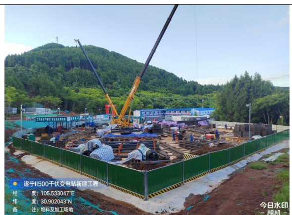
堆料及加工场地临时遮盖
