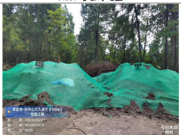
N205 塔表土剥离、临时遮盖
