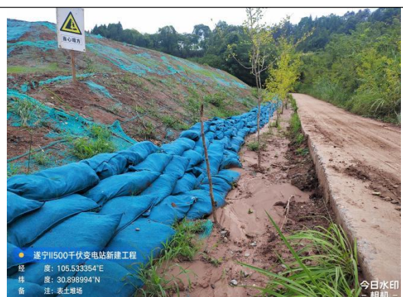
土袋挡墙、临时排水沟、临时遮盖、临时撒草
