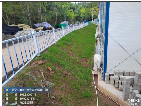
办公生活场地临时排水沟、撒播种草
