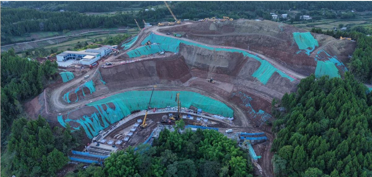
遂宁 II 500kV 变电站
