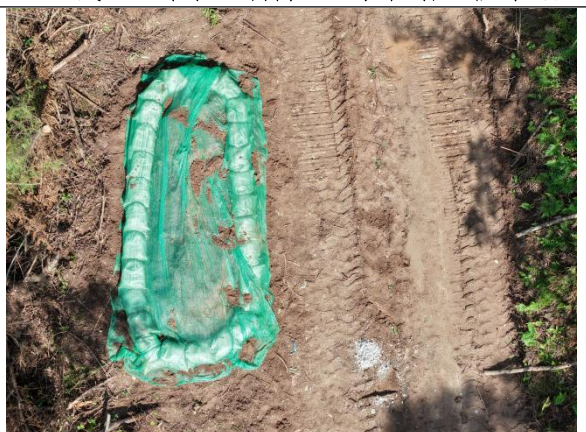
N101 汽运道路表土剥离、临时遮盖
