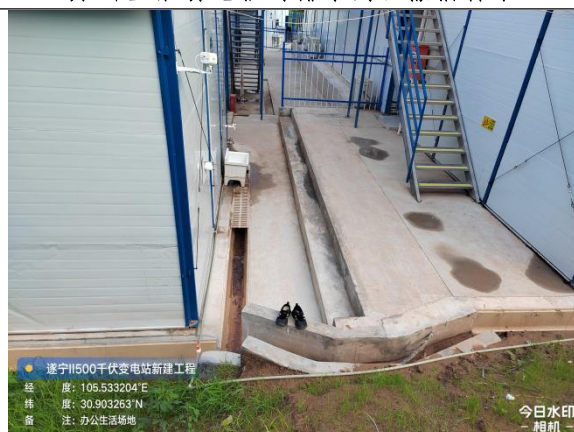
办公生活场地临时排水沟、撒播种草
