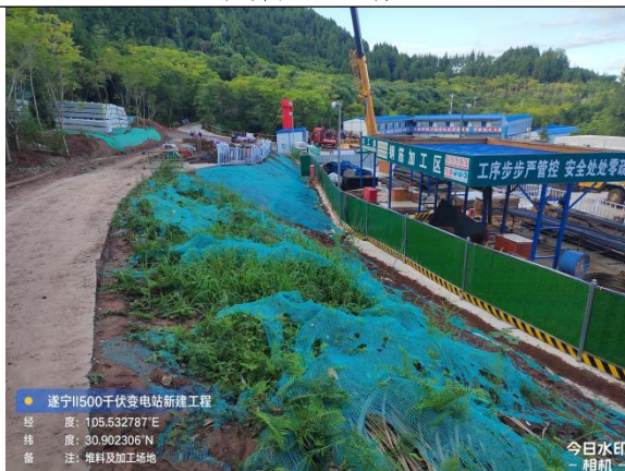
堆料及加工场地临时遮盖、撒播种草
