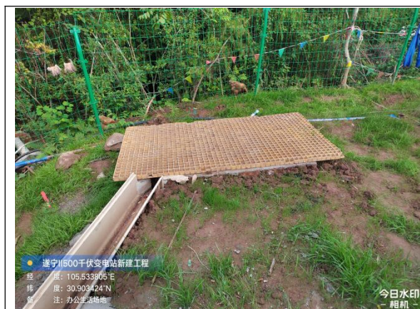
办公生活场地临时排水沟、临时沉沙池
