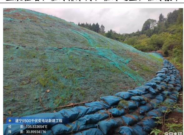
土袋挡墙、临时遮盖、临时撒草
