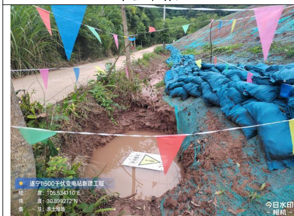
土袋挡墙、临时排水沟、临时沉沙池、临时遮盖、临时撒草
