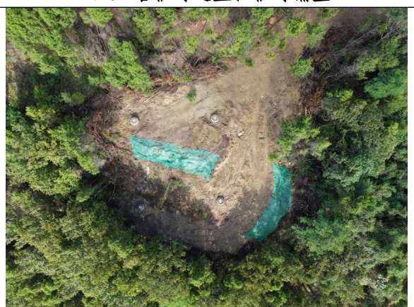
N107 塔临时遮盖
