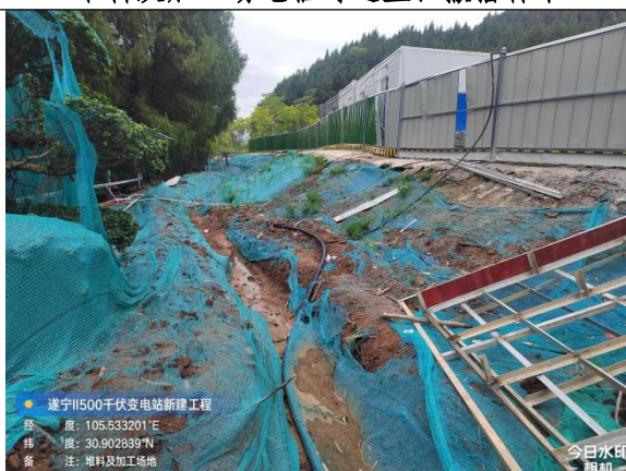
堆料及加工场地临时排水沟、临时遮盖
