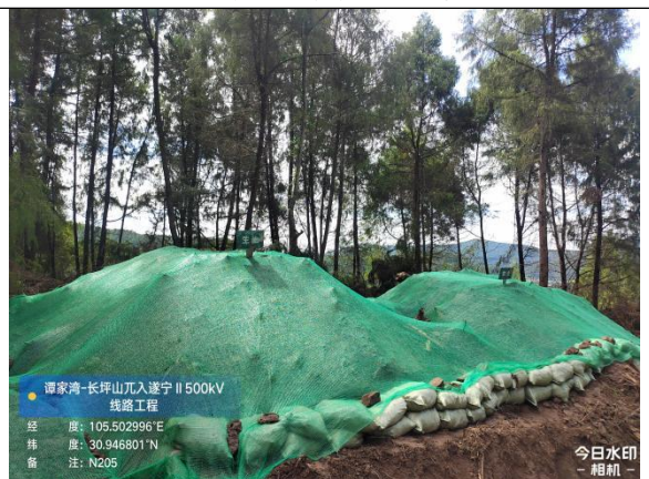
N205 汽运道路表土剥离、土袋挡墙、临时遮盖
