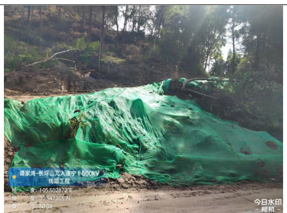
N103 汽运道路坡面临时遮盖
