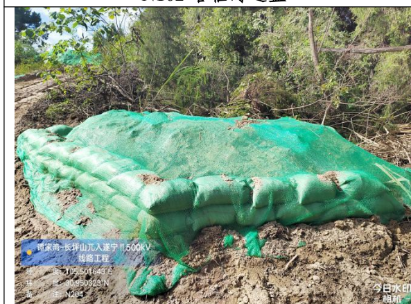
N204 塔表土剥离、临时遮盖、土袋挡墙
