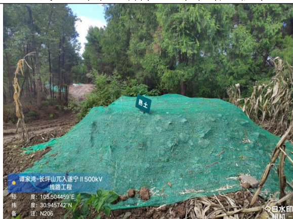
N206 汽运道路表土剥离、临时遮盖
