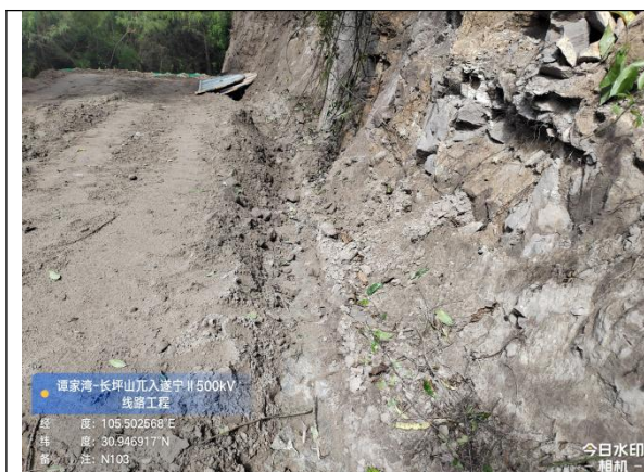
N103 汽运道路临时排水沟
