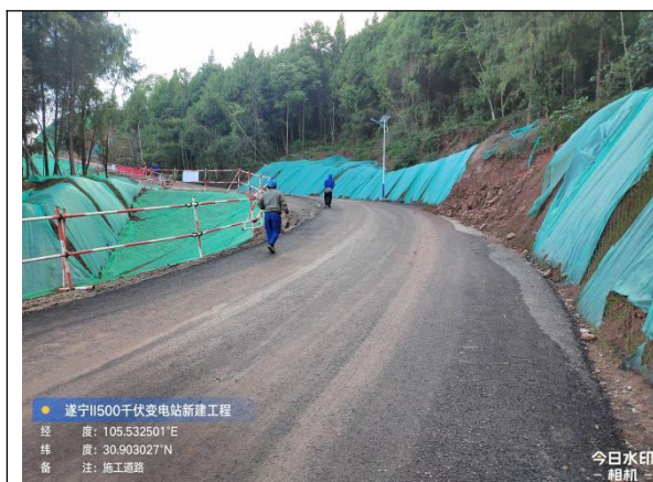
挂网喷播植草护坡、临时遮盖
