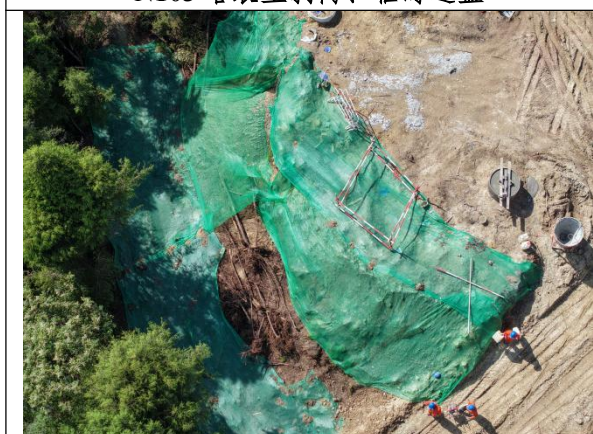
N102 塔临时遮盖
