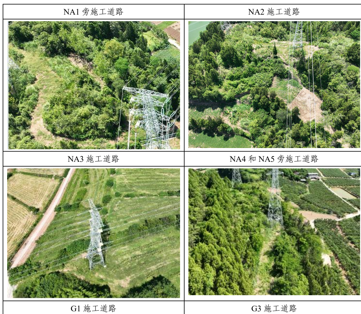
图 1.1-5 部分施工道路恢复后现场调查
