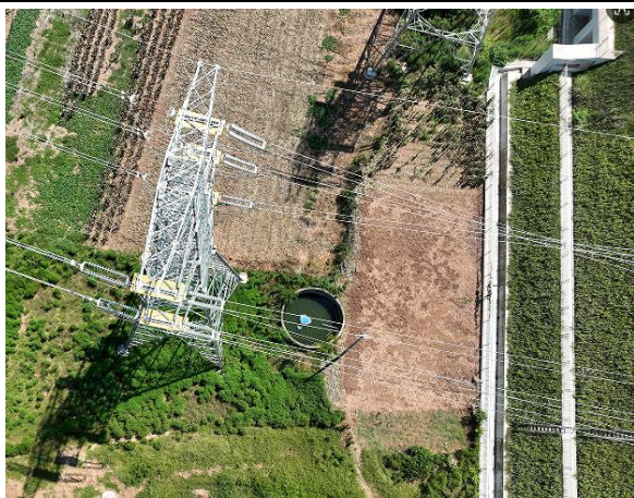
NA1、NB1 旁牵张场
