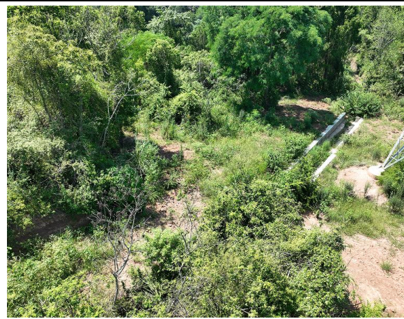
NA3、NB3 旁牵张场
