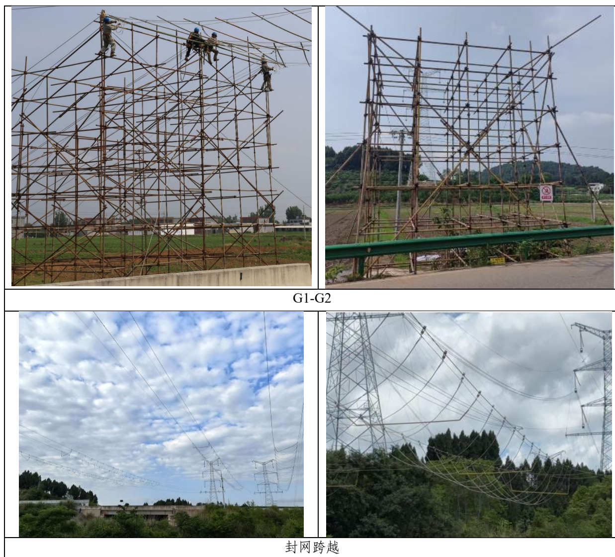
图 1.1-2 部分跨越施工场地及封网跨越施工中现场调查
