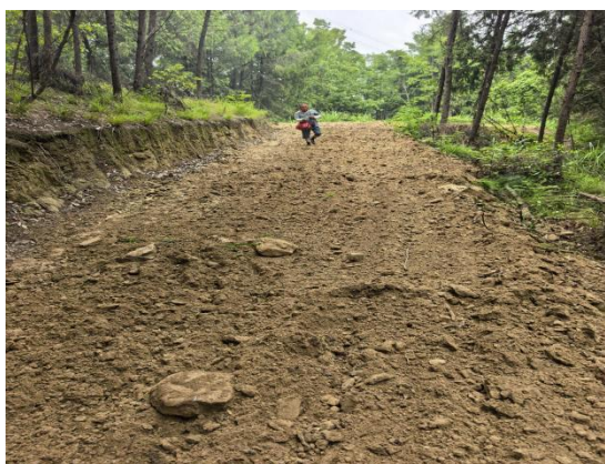
NG21 号塔施工道路土地整治 (2026. 6)
