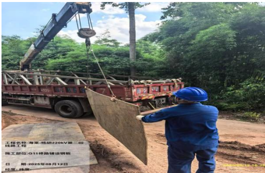
NG11 塔基新建施工便道铺设钢板（2025. 8）
