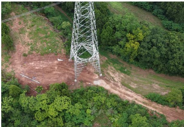
图 1.3-13 G56 塔基区、施工便道区监测点
