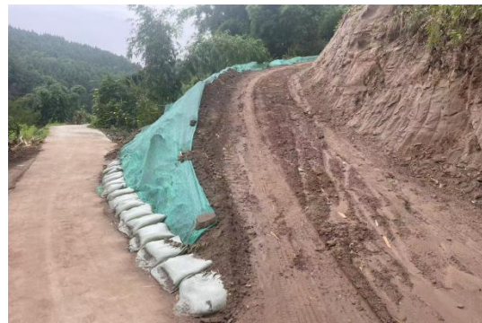
NG2 塔基施工道路临时拦挡、苫盖 (2025. 7)
