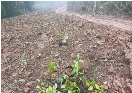
施工道路栽植灌木（2025. 12）
