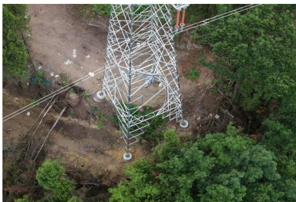
图 1.3-7 G21 塔基区、施工便道区监测点
