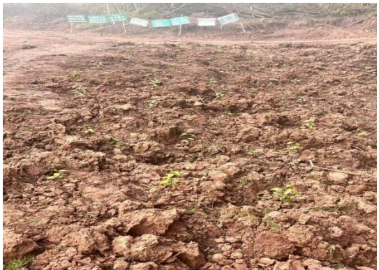
施工道路栽植灌木（2025. 12）
