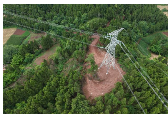
图 1.3-6 G16 塔基区、施工便道区监测点
