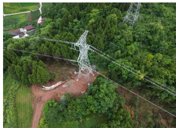
图 1.3-8 G28 塔基区、施工便道区监测点
