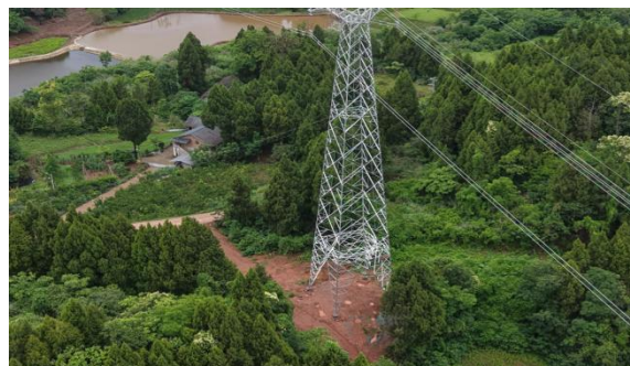
图 1.3-4 H8 塔基区、施工便道区监测点
