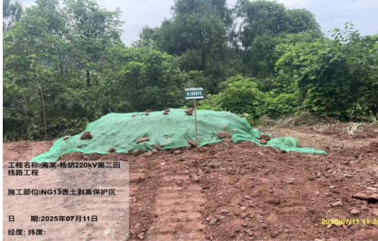
NG13 塔基临时遮盖 (2025. 7)
