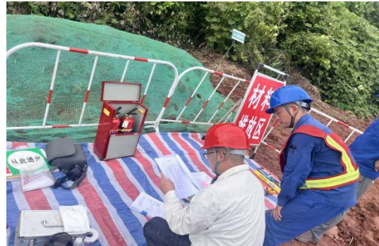
NG9 塔基临时铺垫 (2025. 8)
