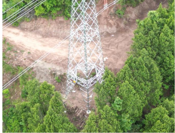
图 1.3-10 G40 塔基区、施工便道区监测点
