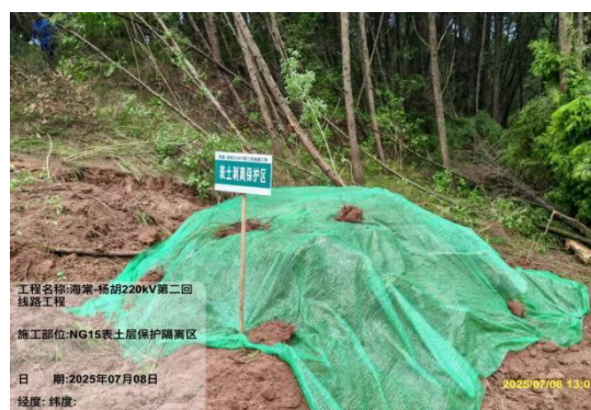
塔基施工区表土剥离 (2025. 7)
