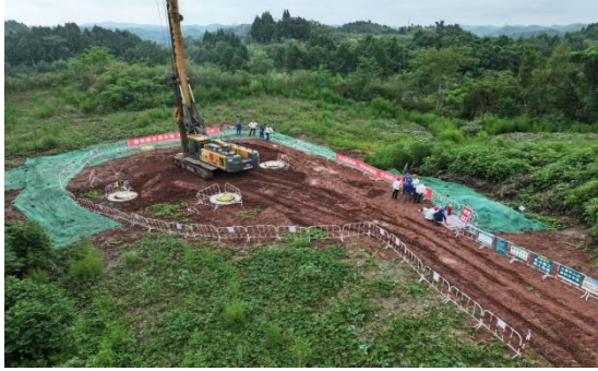
NG9 塔基施工场地临时遮盖 (2025. 8)
