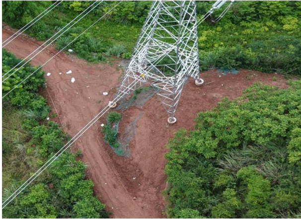
图 1.3-9 G35 塔基区、施工便道区监测点
