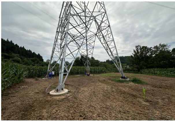
图 1.3-11 G46 塔基区监测点
