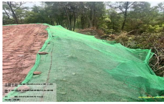
NG6 塔基新建施工便道临时苫盖 (2025. 8)
