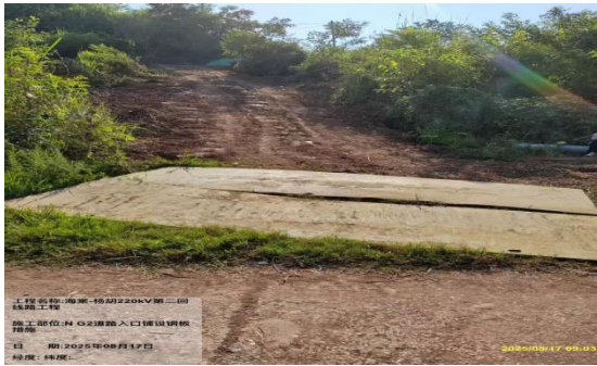
NG2 塔基施工便道拓宽铺设钢板（2025. 8）
