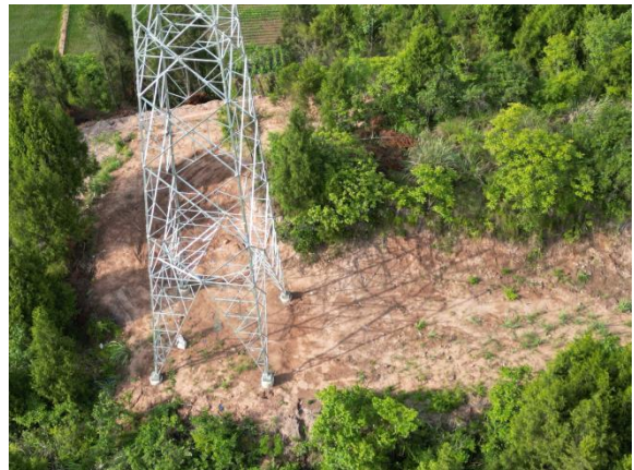
图 1.3-12 G50 塔基区、施工便道区监测点
