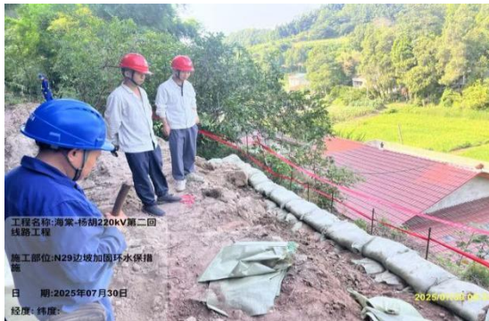
NG29 塔基施工道路临时拦挡 (2025. 7)
