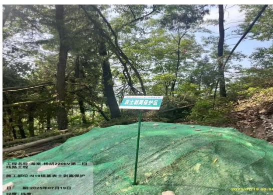
塔基施工区表土剥离 (2025. 7)
