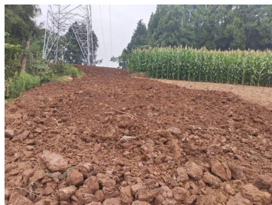
H8 号塔施工道路土地整治 (2026. 6)
