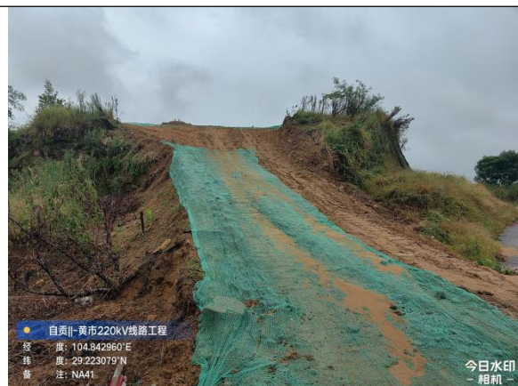
自贡 II~黄市 NA41 汽运道路临时苫盖
