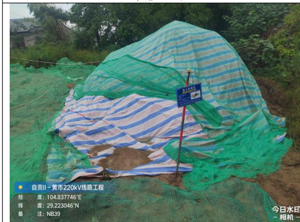
自贡 II~黄市 NB39 塔表土剥离保护
