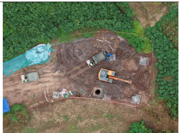
自贡 II~黄市 NA37 塔表土剥离、临时苫盖
