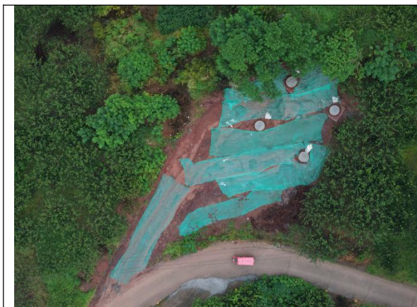
自贡 II~黄市 NA40 汽运道路临时苫盖
