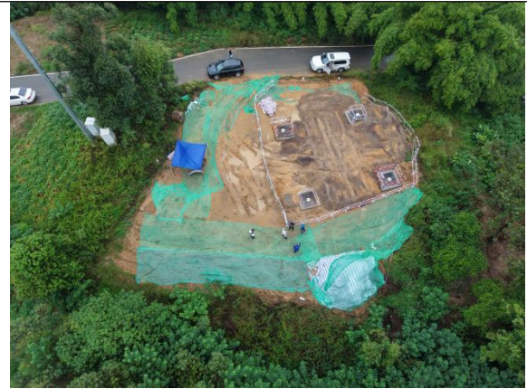
自贡 II~黄市 NB39 塔表土剥离、临时苫盖
