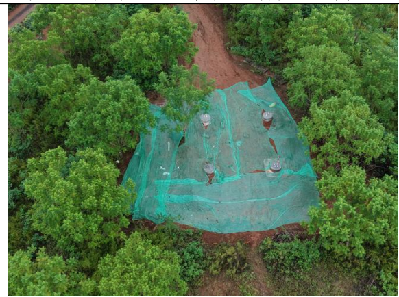
自贡 II~黄市 NB27 塔临时苫盖
