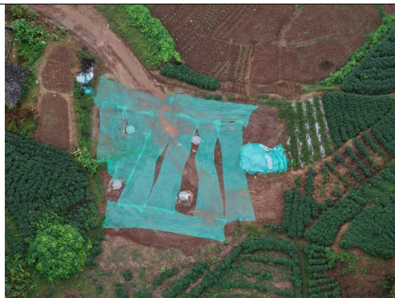
自贡 II~黄市 NA27 塔表土剥离、临时苫盖
