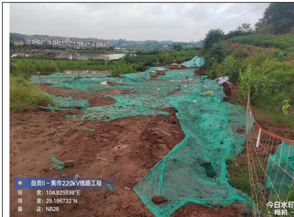
自贡 II~黄市 NB28 塔表土剥离、临时苫盖、临时排水沟
