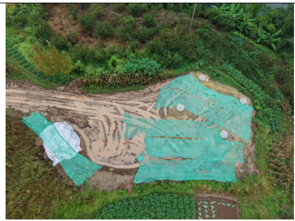
自贡 II~黄市 NB40 塔表土剥离、临时苫盖
