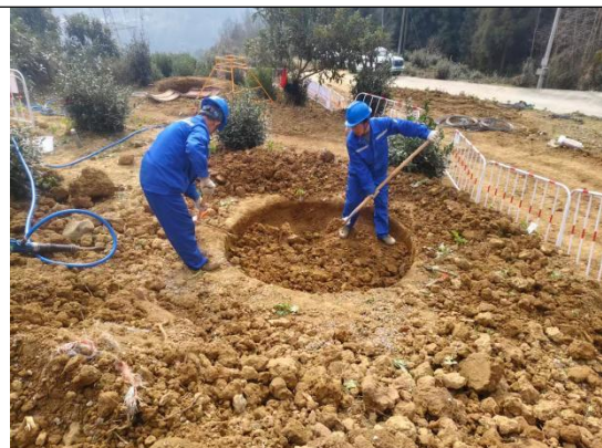
铁塔施工期照片
