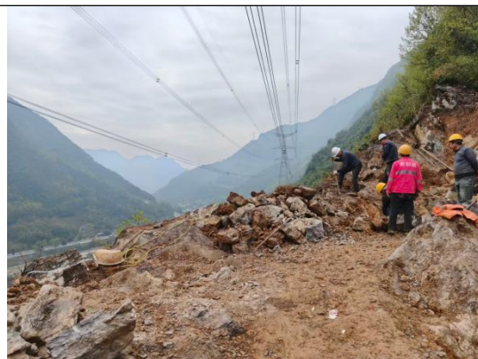
开方工程施工期照片
