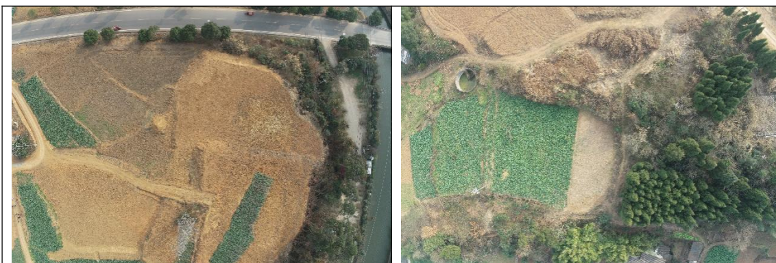
115#-116#改造段原地貌
