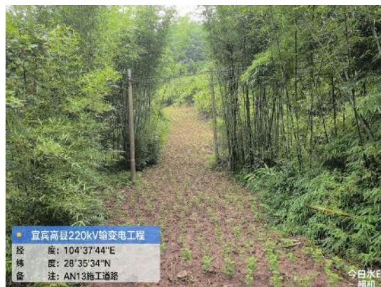
施工道路植被恢复
