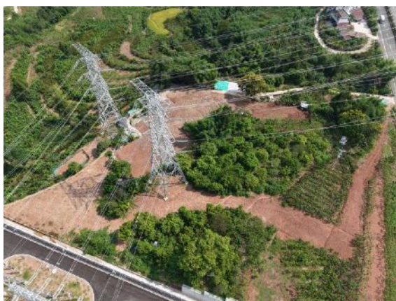
A22 塔基施工场地
