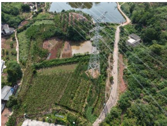
B6 塔基施工场地
