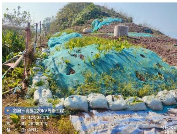
塔基临时堆土临时苫盖、拦挡
