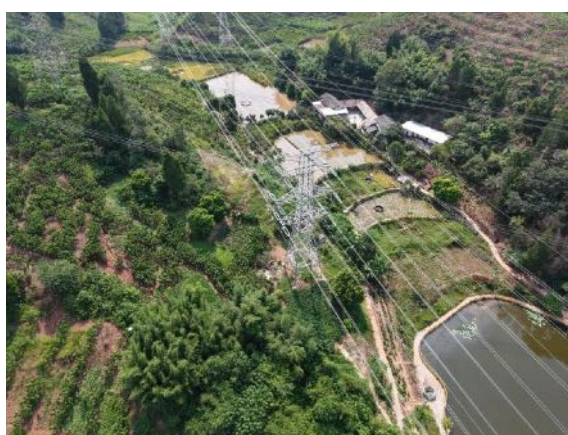
B5 塔基施工道路
