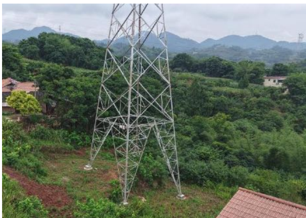
塔基及临时占地绿化
