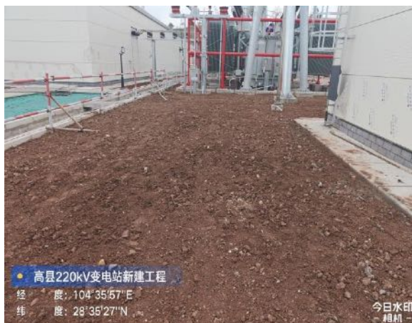
变电站内土地整治及表土回覆
