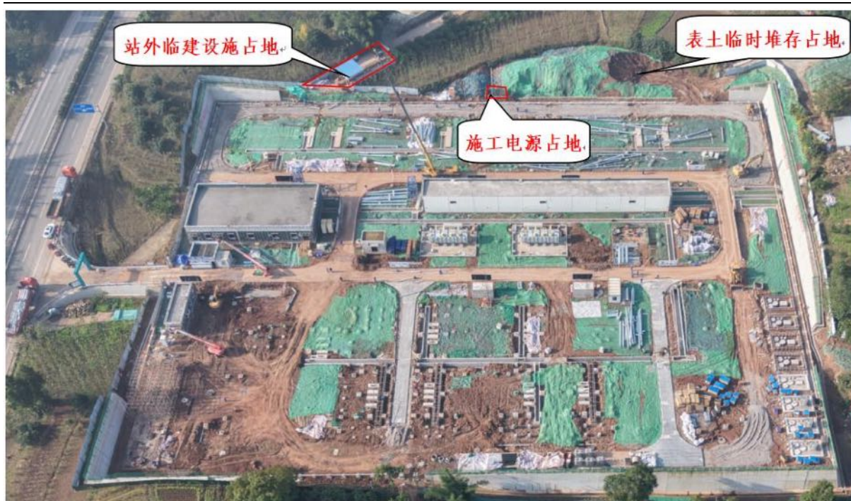
图 1.1-2 高县 220kV 变电站及叙府 500kV 变电站 220kV 间隔扩建工程
