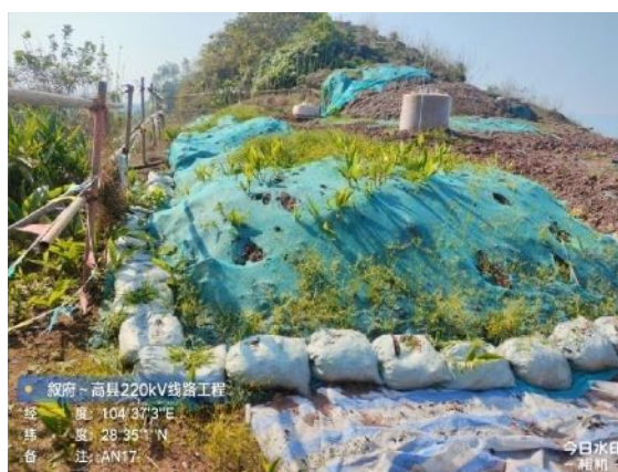
塔基区表土剥离
