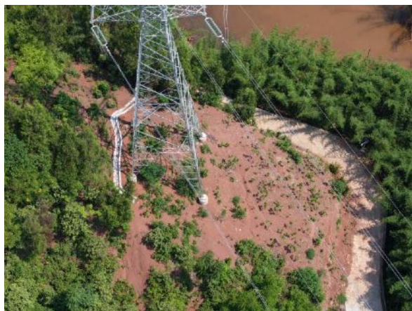
塔基区截排水设施
