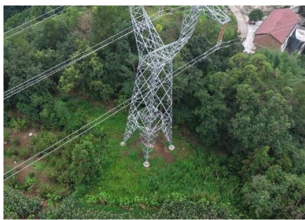
塔基及临时占地绿化
