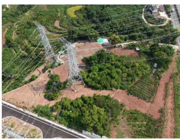
A26 施工道路
