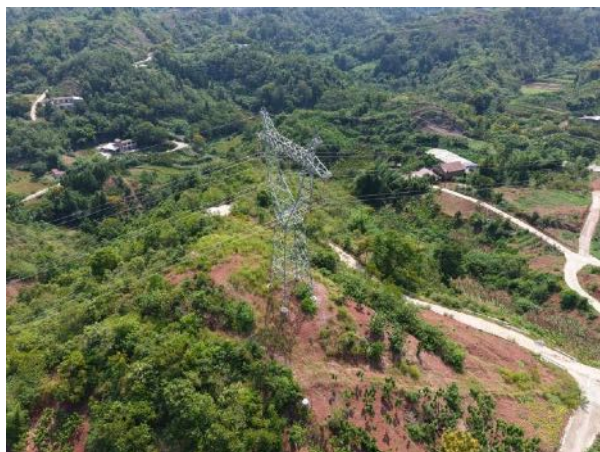
A8 塔基施工场地
