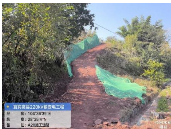
施工道路临时苫盖
