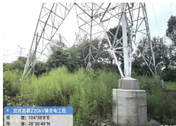
塔基及临时占地绿化
