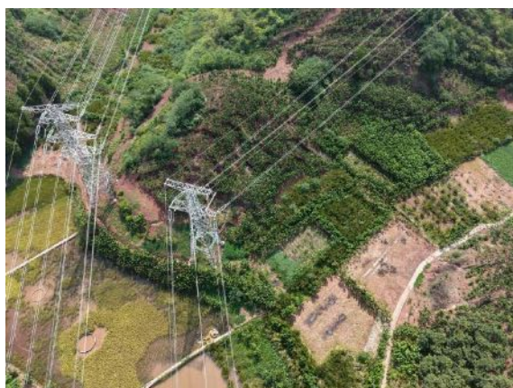
A23 塔基施工场地
