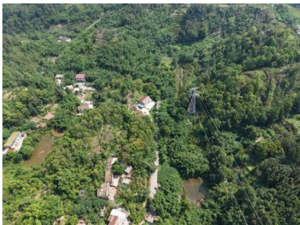
A13 施工道路
