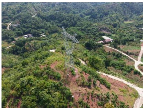
A8 施工道路
