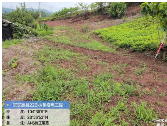
施工道路植被恢复
