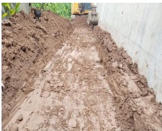
高县变电站临时排水
