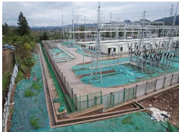
变电站-砖砌排水沟
