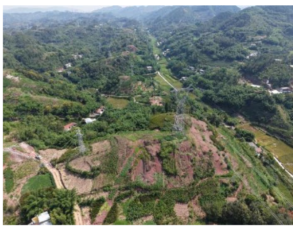
A15 施工道路
