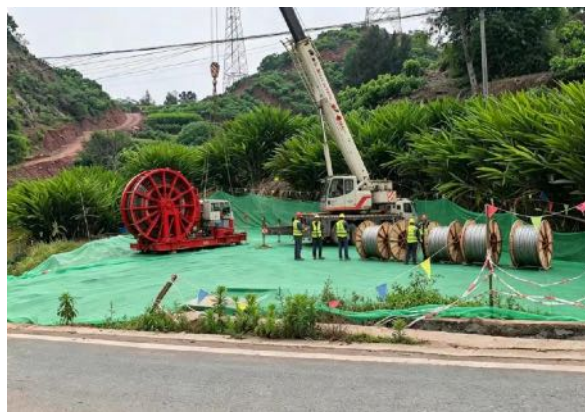
牵张场临时铺垫
