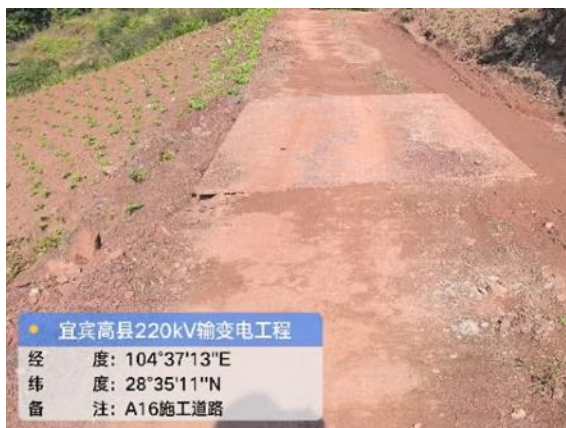
施工道路铺垫钢板
