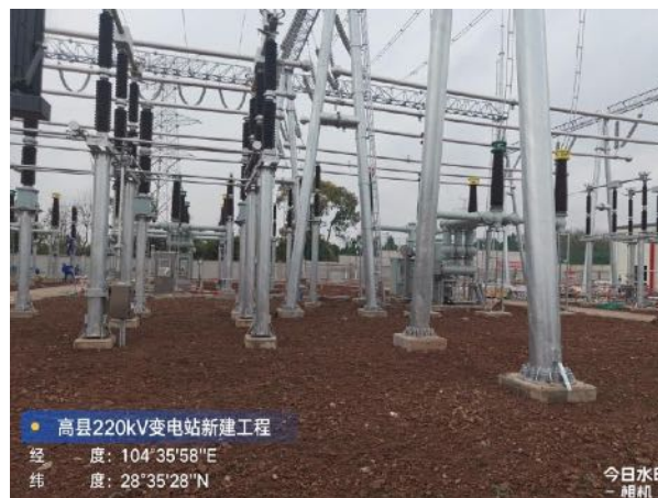
变电站内土地整治及表土回覆
