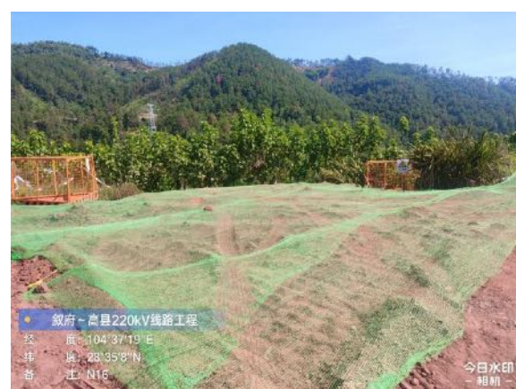
塔基临时堆土临时苫盖
