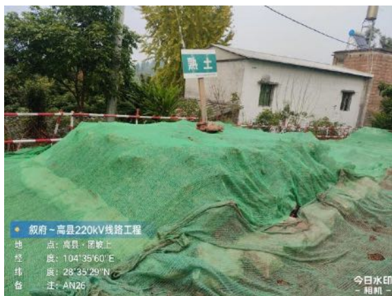
塔基区表土临时拦挡、苫盖
