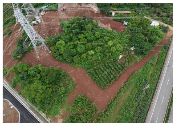
施工道路土地整治
