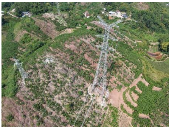
B3 塔基施工场地
