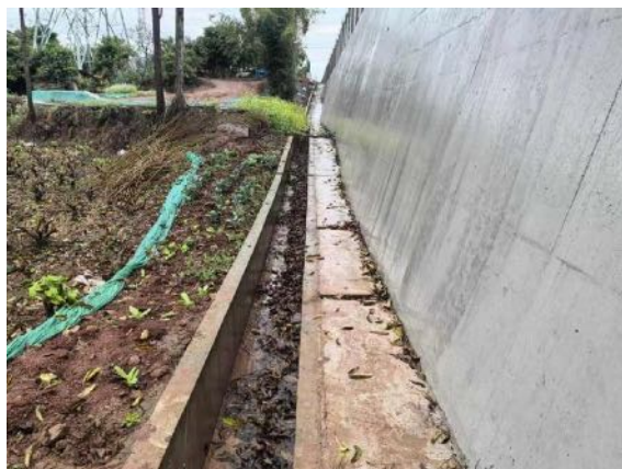
变电站-混凝土排水沟
