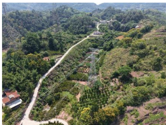
A9 施工道路
