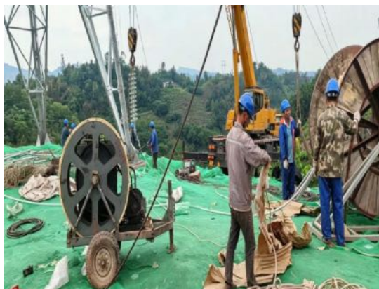
牵张场临时铺垫
