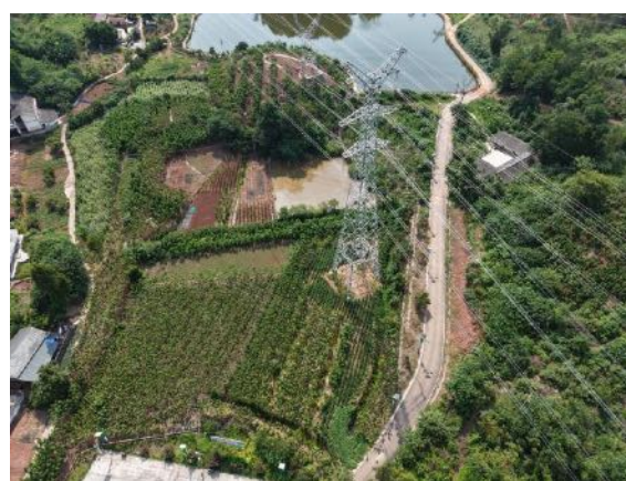
B6 塔基施工道路
