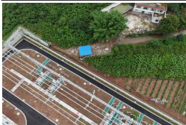
站外临建设施占地（钢筋、木材加工场）
