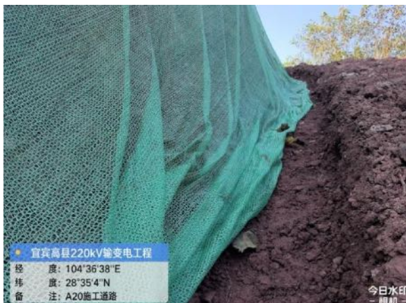
施工道路临时排水
