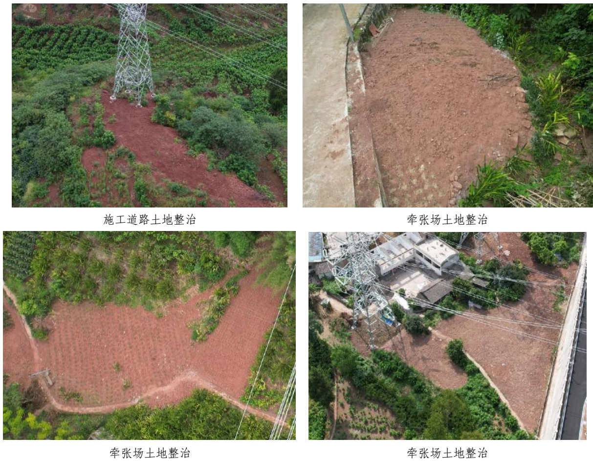
图 3.6-1 宜宾高县 220 千伏输变电工程工程措施照片
