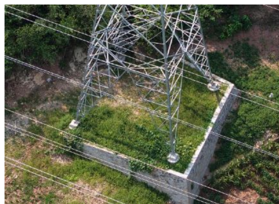
塔基浆砌石挡墙
