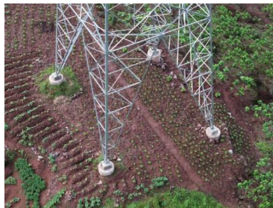
塔基及临时占地绿化
