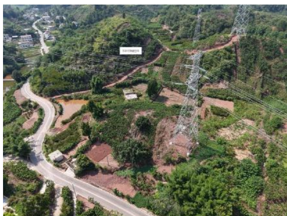
A20 塔基施工场地
