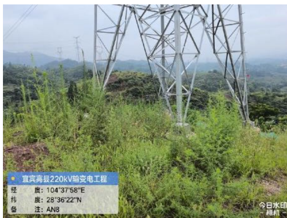
塔基及临时占地绿化
