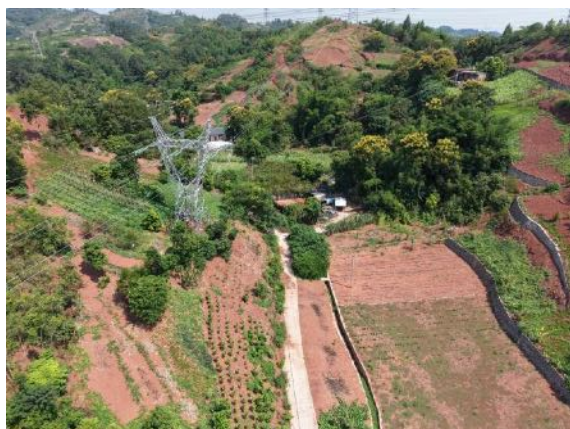
A3 施工道路
