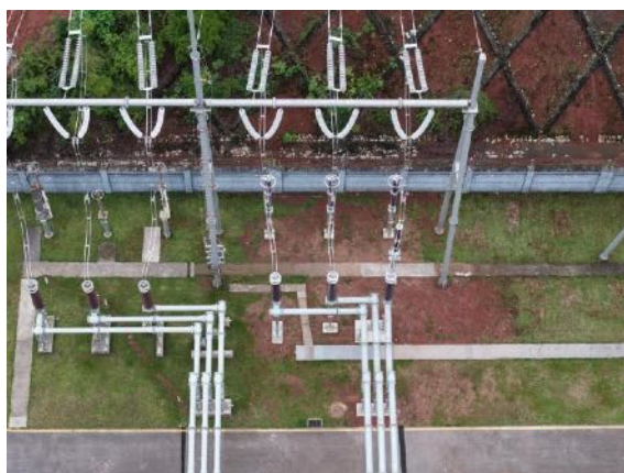
间隔扩建工程撒播草籽绿化
