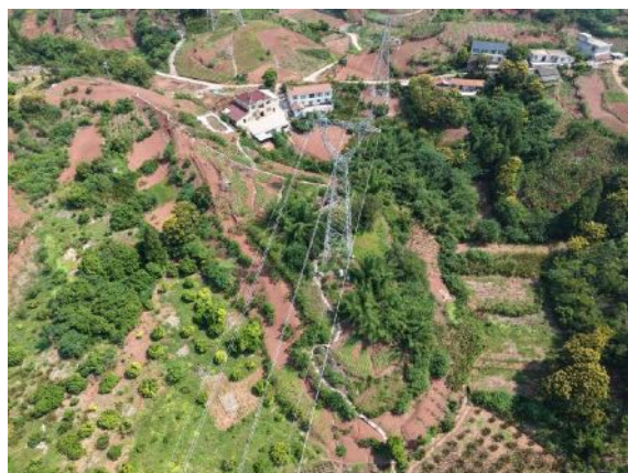
A5 施工道路
