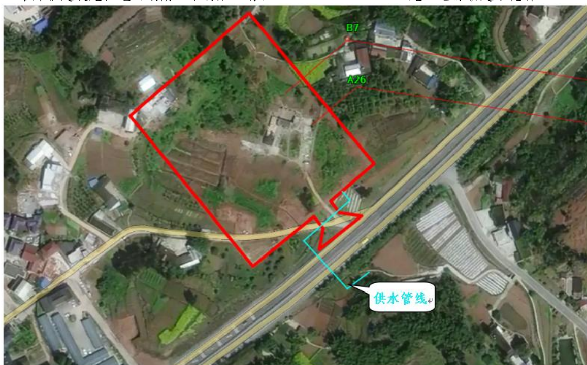
高县 220kV 变电供水管线
