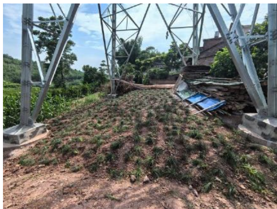
塔基及临时占地绿化
