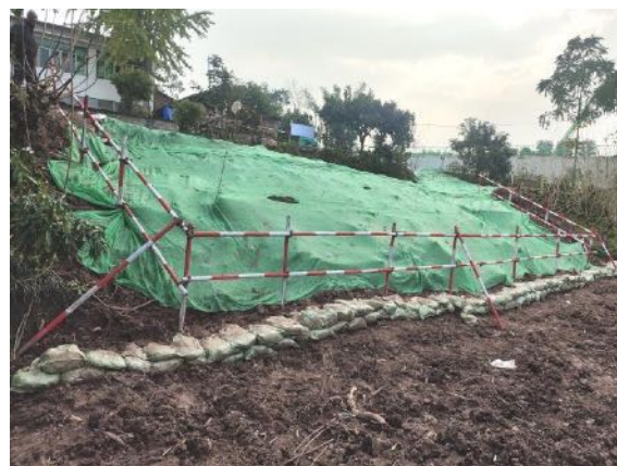
塔基区表土临时拦挡、苫盖
