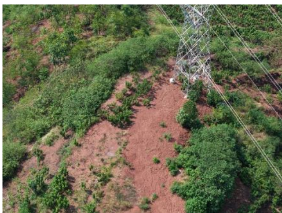
A22 塔基施工场地
