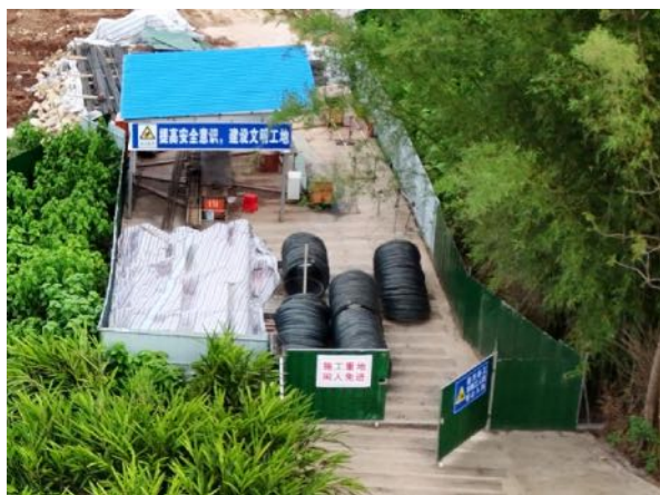
站外临建设施占地(钢筋、木材加工场)
