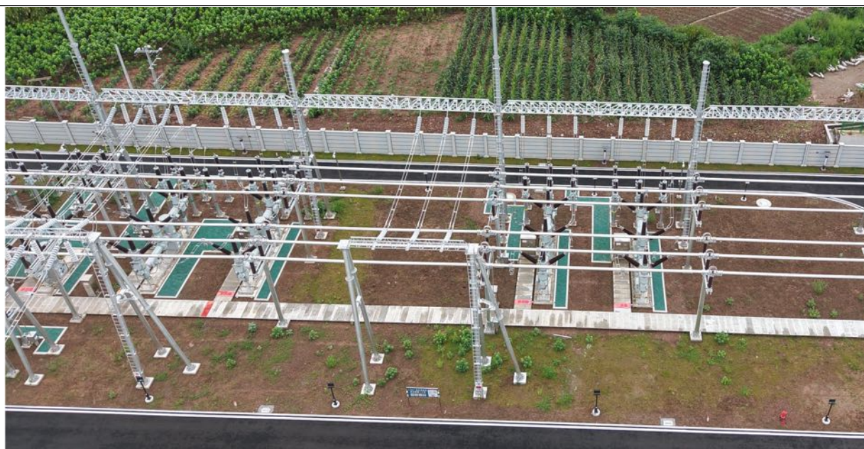
高县 220kV 变电站站内撒播草籽绿化 2026.7
