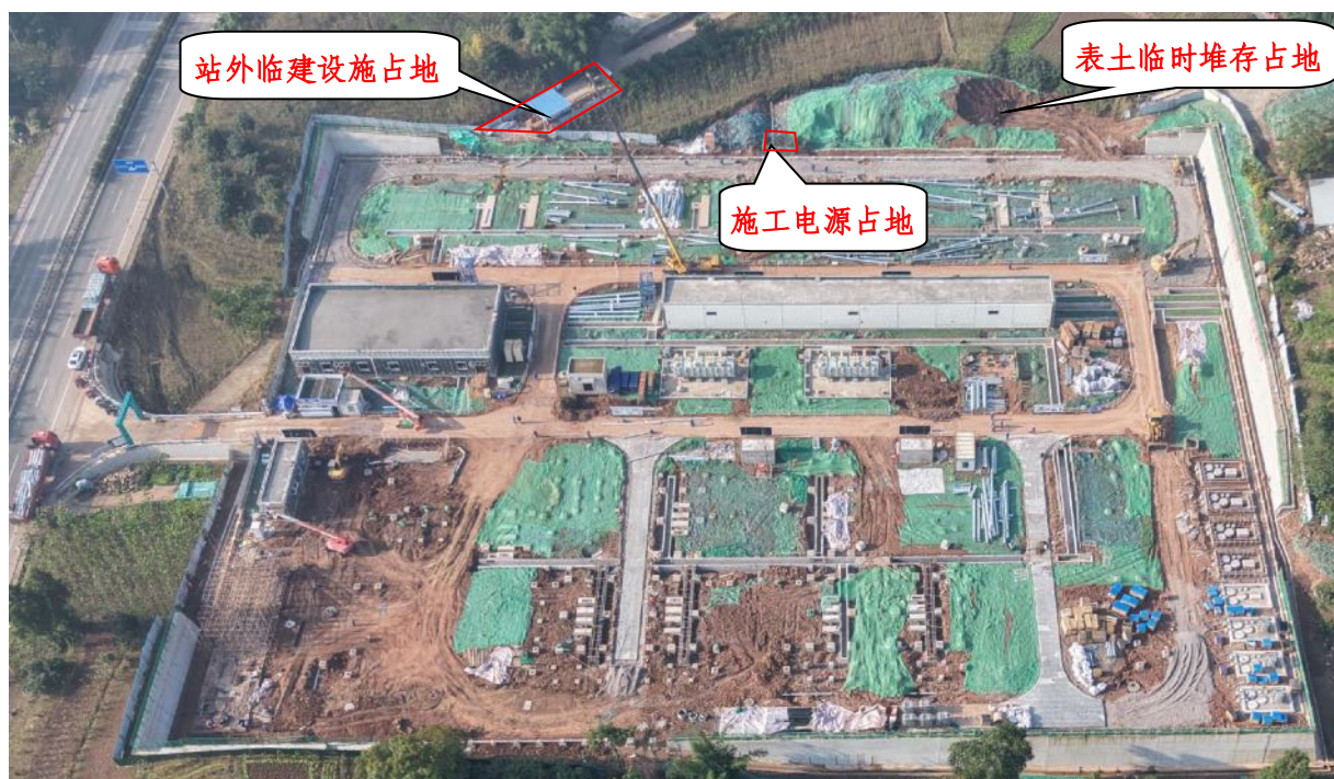
高县 220kV 变电站施工现场布置情况
