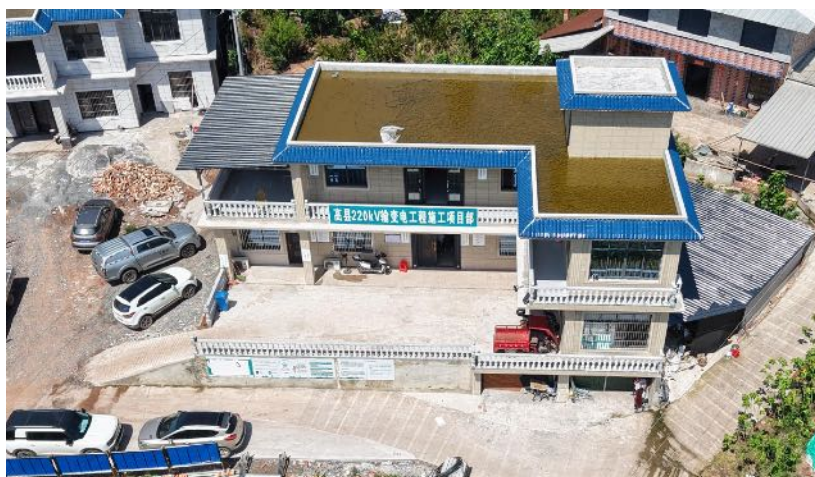
高县 220kV 输变电工程施工项目部
