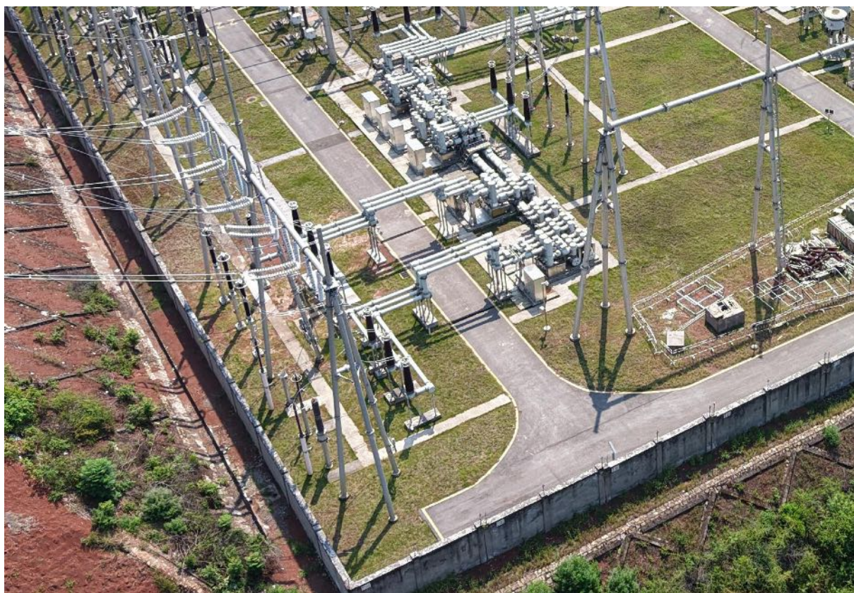
间隔扩建区撒播草籽绿化 2026.9
