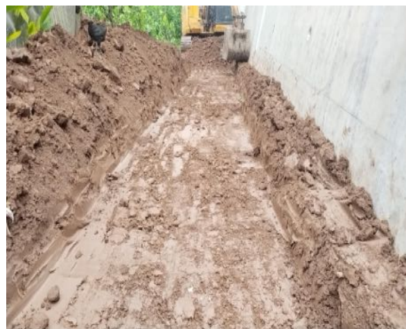
站外临时排水沟开挖 2025.6
