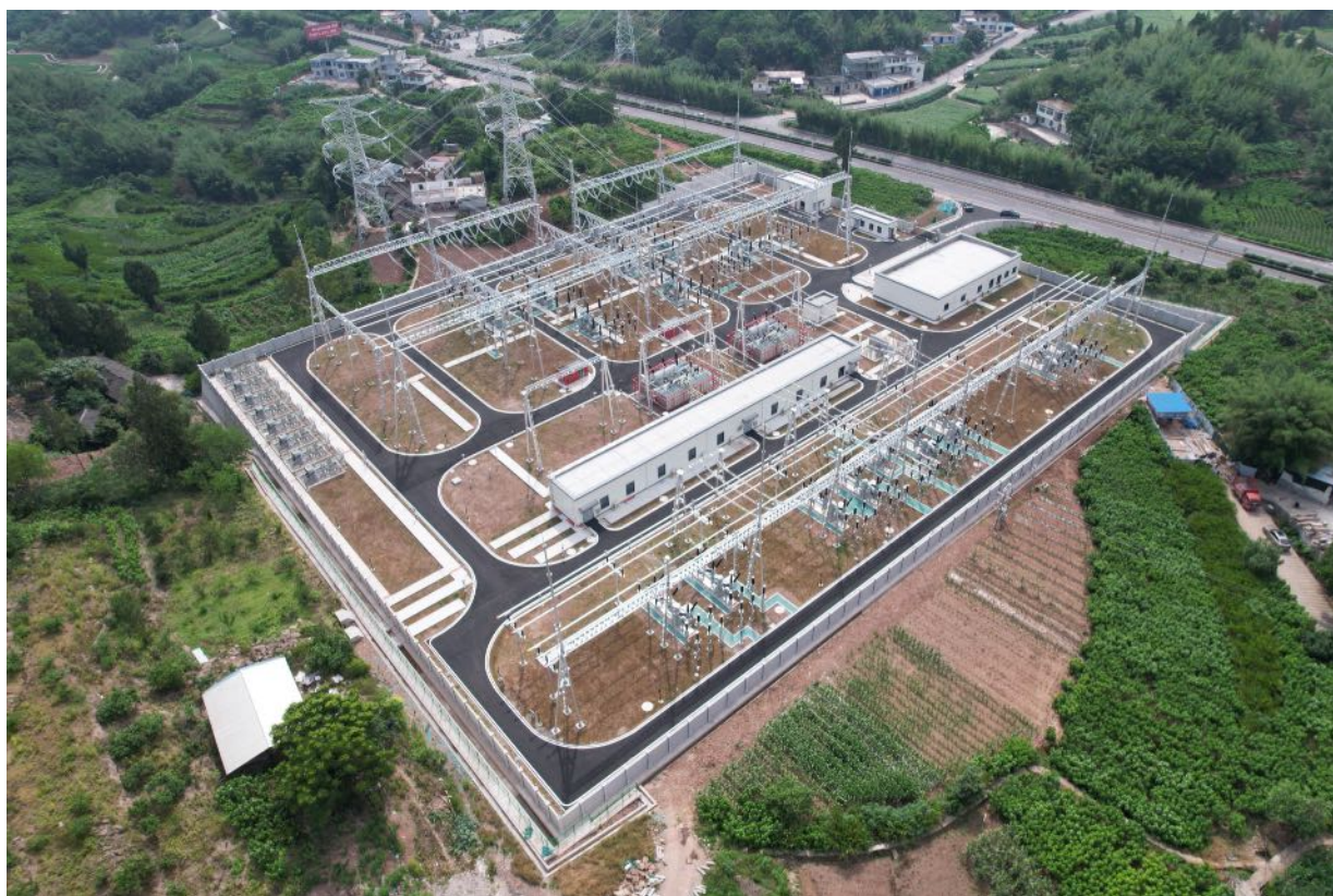
高县 220kV 变电站站内撒播草籽绿化 2026.6
