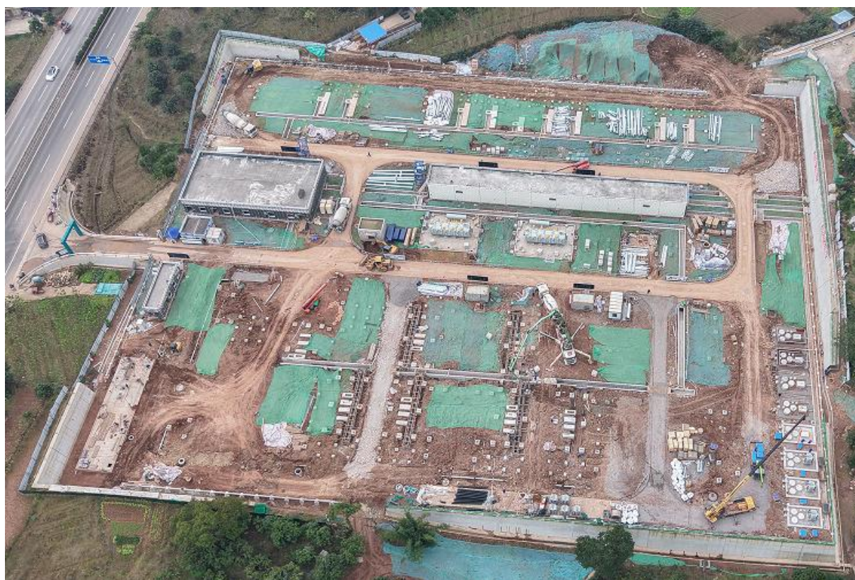
高县 220kV 变电站闲置施工区域临时苫盖 2025.11
