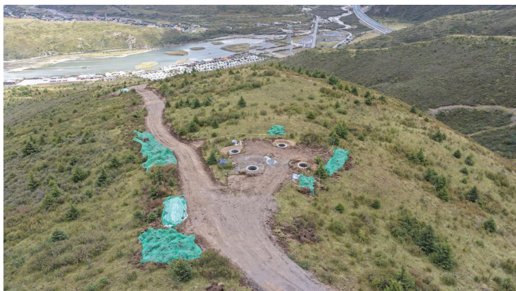
图 2 LR036 塔基区无人机航拍
