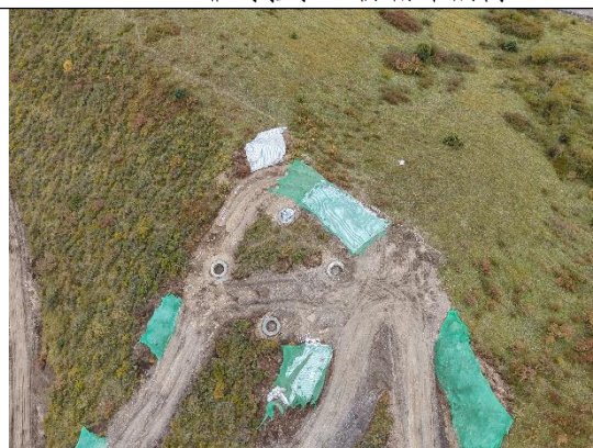
HL055 临时苫盖
