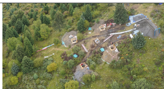
HR104 临时拦挡、防雨布隔离
