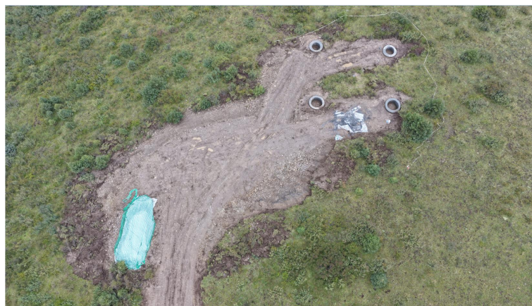
图1 LH039塔基区无人机航拍
