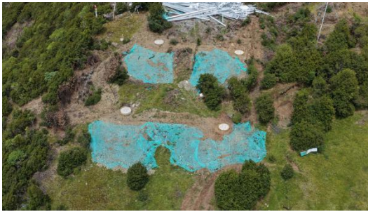
N73 临时苫盖
