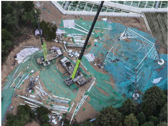
NBR1 临时苫盖
