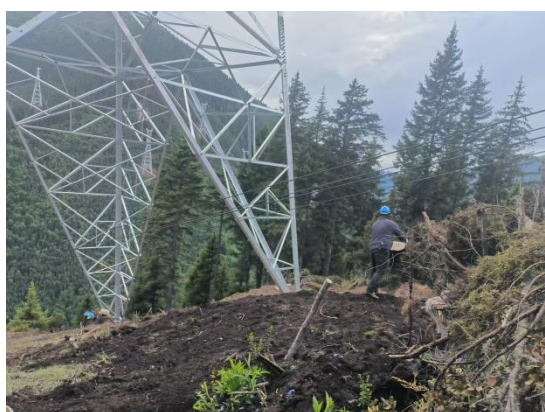
N131 下料场土地整治、撒播草籽
