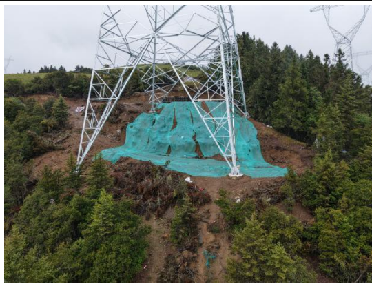
NBL2 临时苫盖
