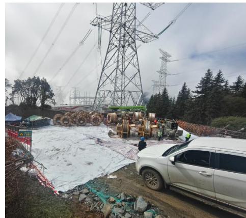
NBR1 附近牵张场铺垫隔离
