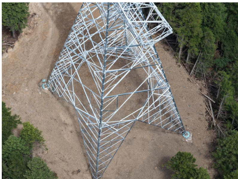
图2 N189塔基区无人机航拍
