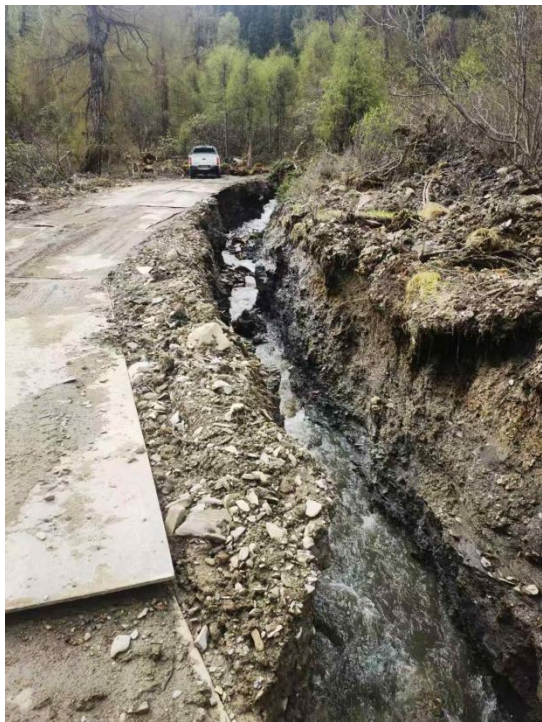
NAR42 施工道路钢板铺设、临时排水沟
