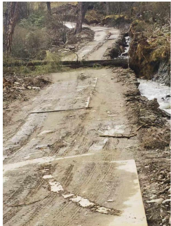
NAR20 施工道路钢板铺设、临时排水沟
