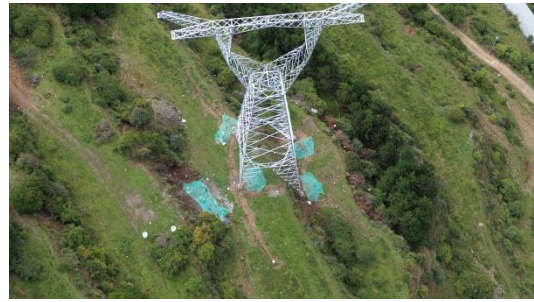
N38 临时苫盖
