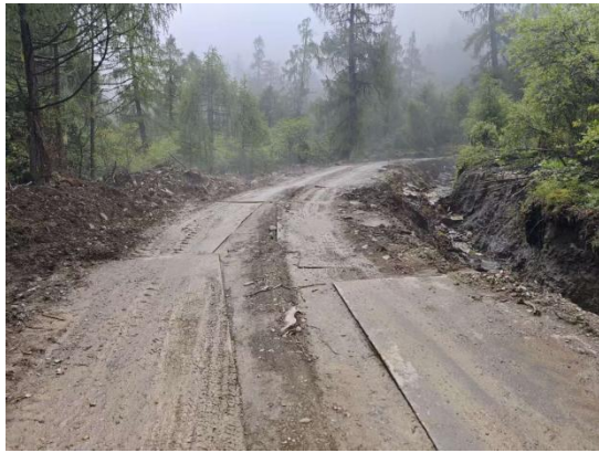
NBR50 施工道路钢板铺设、临时排水沟
